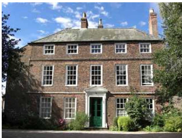
図5 キャロルの一家が住んでいたクロフト村の牧師館(2007年8月30日筆者撮影)
