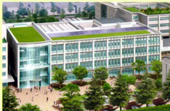
建設中の新ユーエンジニア館
